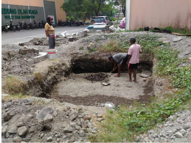
Gambar 3.6. Pembuatan Ballast Box: Pembersihan Lokasi
