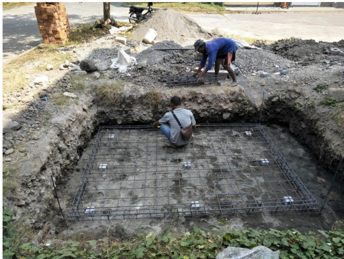
Gambar 3.7. Pembuatan Ballast Box: Pemasangan Tulangan Pelat
