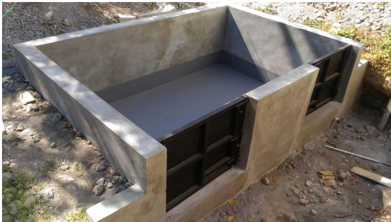
Gambar 3.9. Kondisi Ballast Box Lapangan
