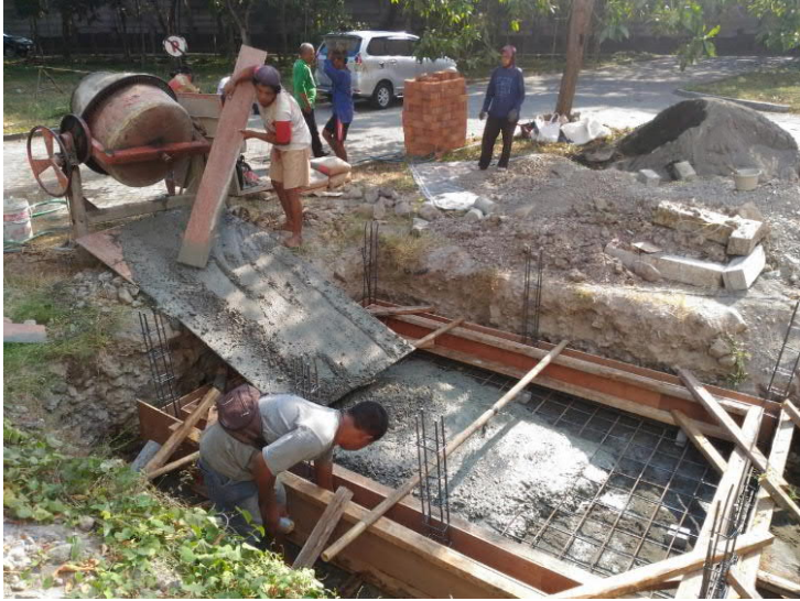
Gambar 3.8. Pembuatan Ballast Box: Pengecoran Ballast Box
